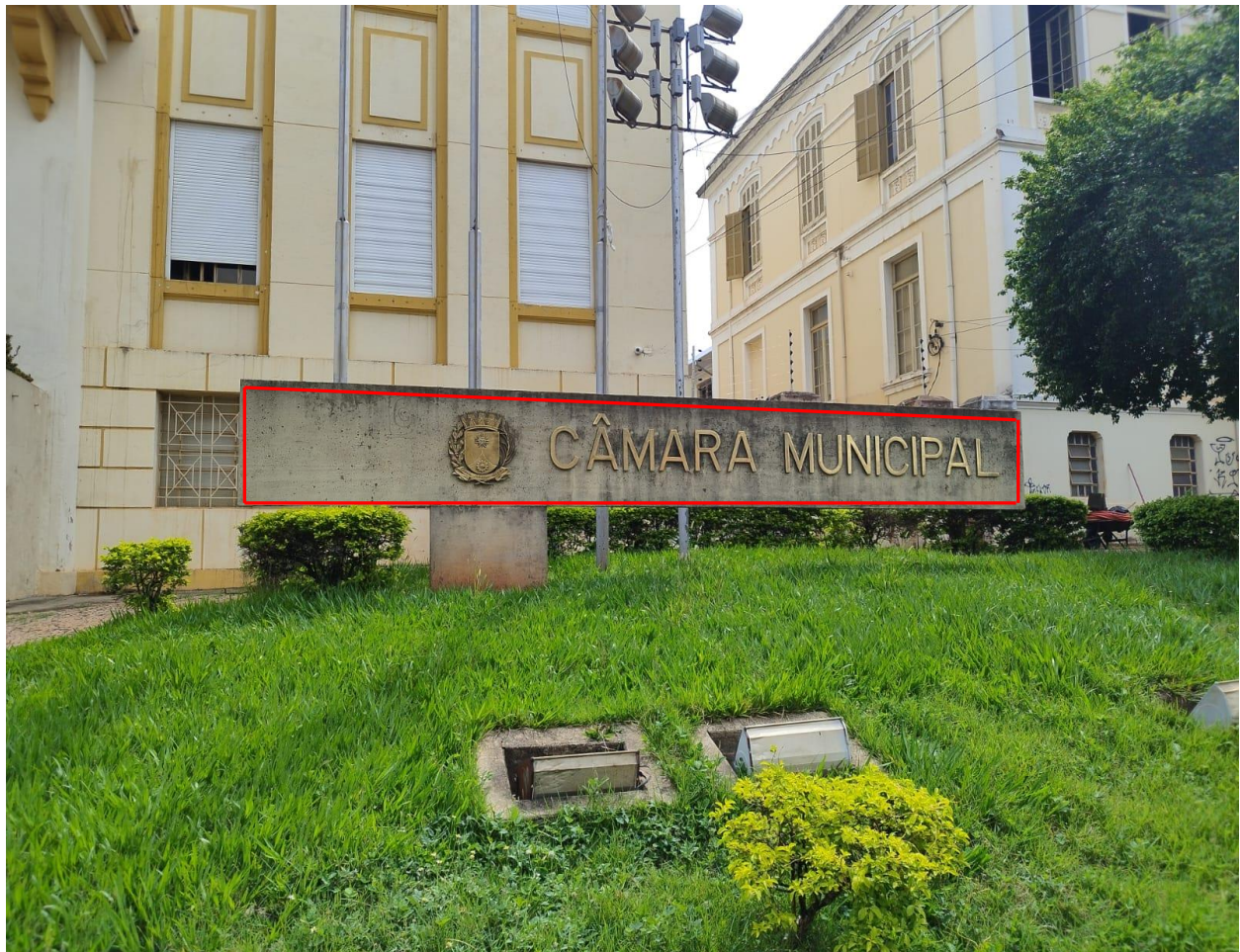
Figura* 03 – Vista frontal do pórtico de concreto do prédio sede da Câmara Municipal onde as linhas vermelhas indicam os locais para instalação da iluminação de natal
