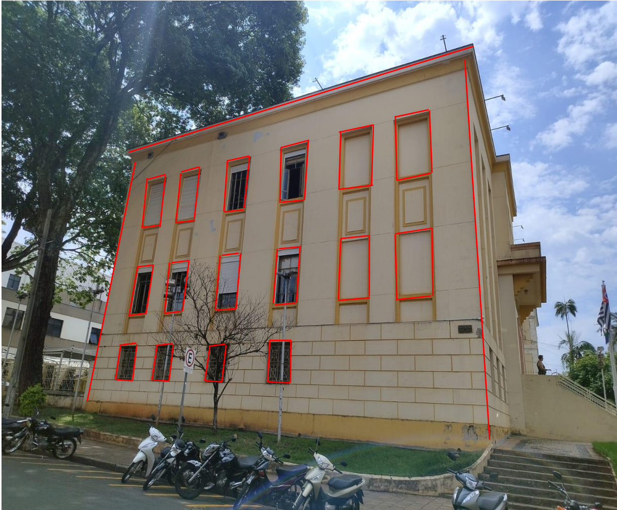
Figura* 04 – Vista lateral do prédio sede da Câmara Municipal onde as linhas vermelhas indicam os locais para instalação da iluminação de natal: janela, platibanda e laterais
